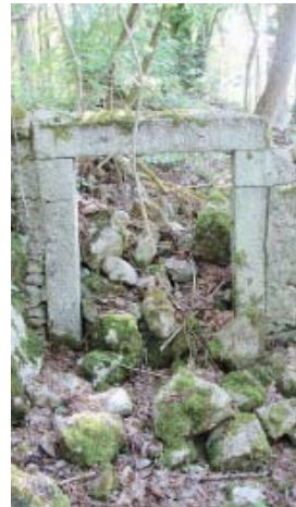
Les Plagnes. La première mention remonte à 1671. Restaurée en 1708, il ne reste aujourd'hui que des ruines. Cette grange était séparée en 2 pièces réservées aux bêtes.
